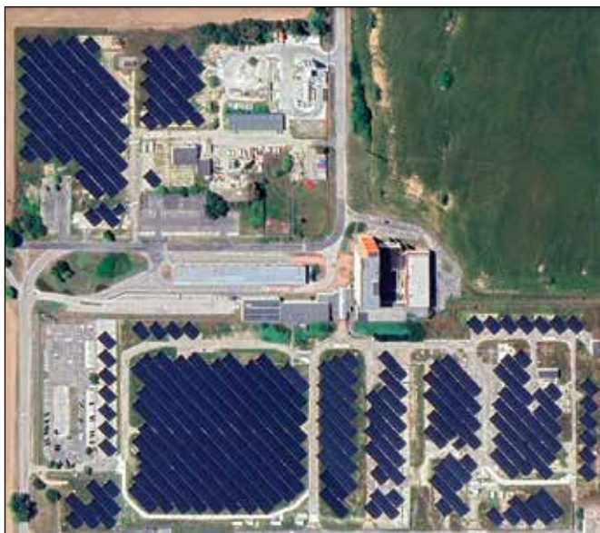
■ Fotovoltaická elektrárňa FVE 1 (pohľad zhora)
