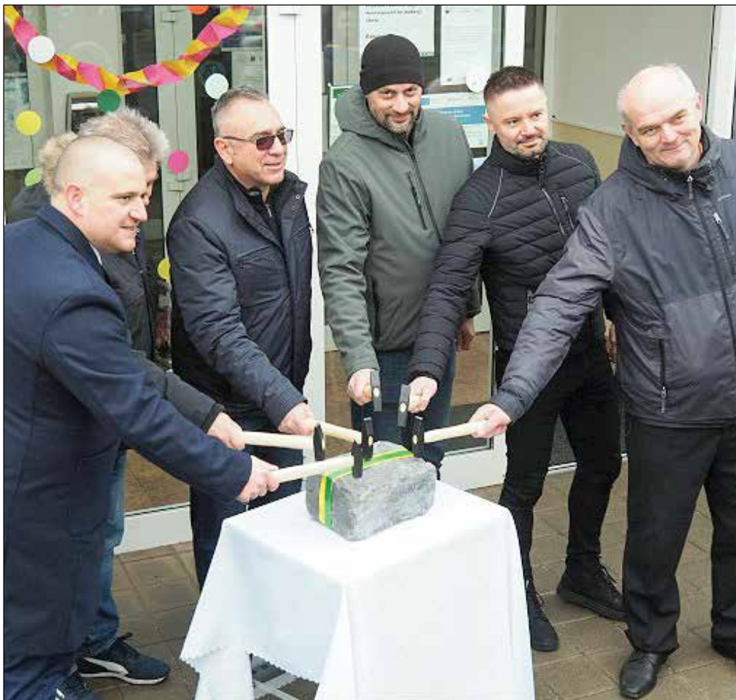
■ Mgr. David Matula, starosta obce Boleráz (vľavo) a zástupcovia dodávateľov poklepali 27.1.2026 základný kameň modernizácie základnej školy
